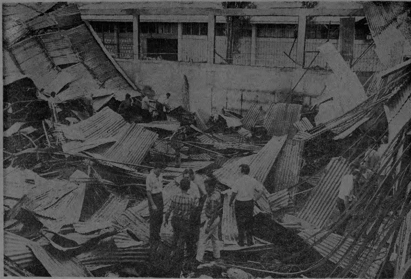
ERA UNA FABRICA. — La foto de Córdoba no muestra el estado en que quedó la fábrica de tejidos Karolina, ubicada en Ipís de Guadalupe que se incendió anoche. Las pérdidas se
